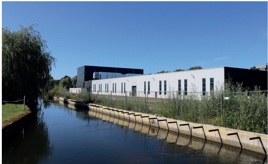
Kompetenzzentrum für Compoundierung: In Schwendi stellt der Verpackungsspezialist Kunststoffgranulate selbst her und entwickelt dessen Eigenschaften kontinuierlich weiter. © Südpack
